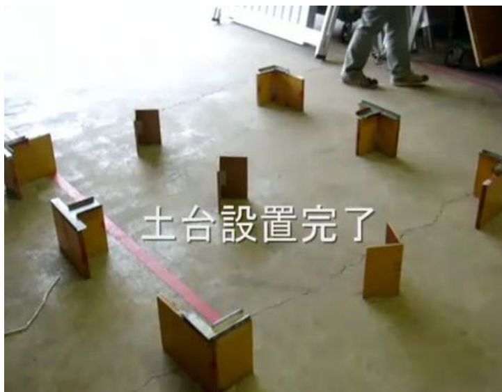
↑ 上記は天板2枚の場合の部材配置です。 4枚の場合は中心に「十字」部材となります。
